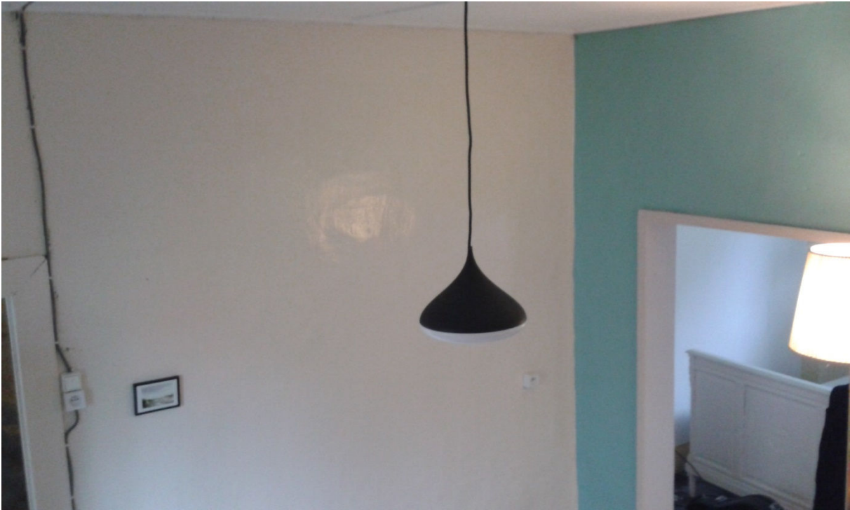
Onbewoond? Renovatie elektriciteit
