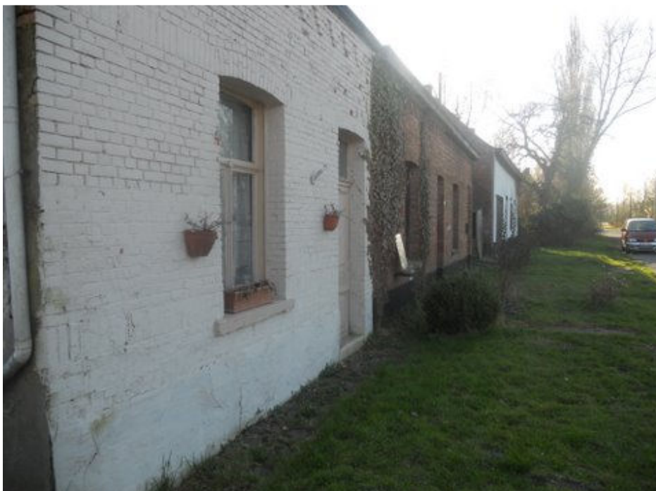
Zicht op de landwerkershuisjes nr. 122-116 aan de overzijde van nummer 111
